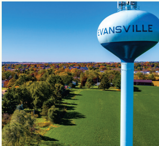
Evansville Water & Light, est. 1901
